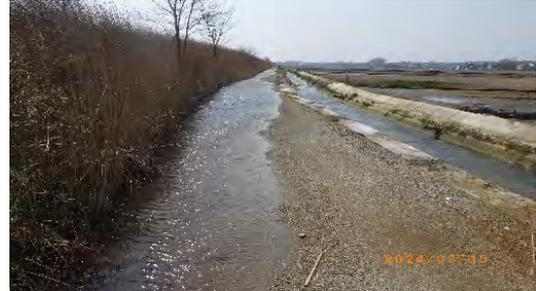
図 管理道路上のしみだし、き裂からの噴出による水溜（左側が堤体、2024年3月15日）
