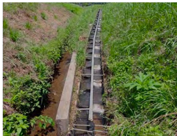
図3. 水田魚道の一例、左は全国でみられる千鳥X型。右はその弱点を改良・開発した土嚢型。両タイプとも多くの魚介類の遡上がみられるが、土嚢型の方が設置や管理が簡単である（立川ほか 未発表）。
